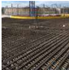
MONTAJE EN OBRA
