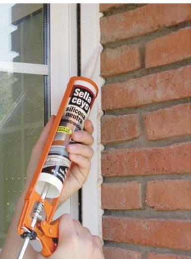
Para realizar una buena junta en el exterior, necesitaremos un producto de alta adherencia sobre los materiales de obra, buena capacidad de relleno y sellado, y una excelente resistencia a condiciones duras de intemperie.
